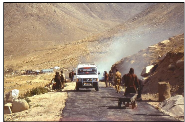
Obnova in asfaltiranje ceste proti cestnemu prelatu Khardungla je mogoča samo poleti
